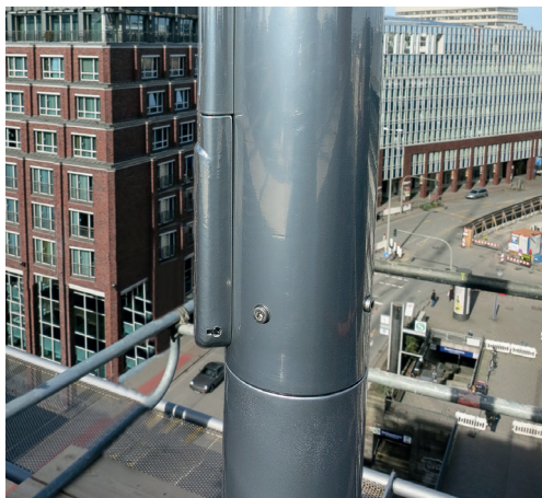
Mastrohr 2-teilig mit Drehlagerung, Fassadenmontage
